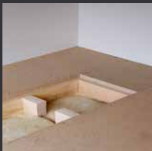
Golvbjälkar och kortlingar, c-c 300 mm.
